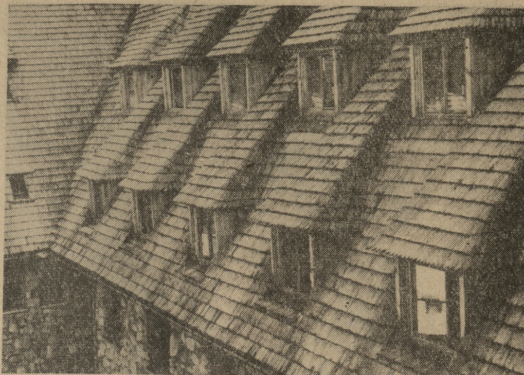
Fragment dachu nowego Domu Turystycznego w Zakopanem.
