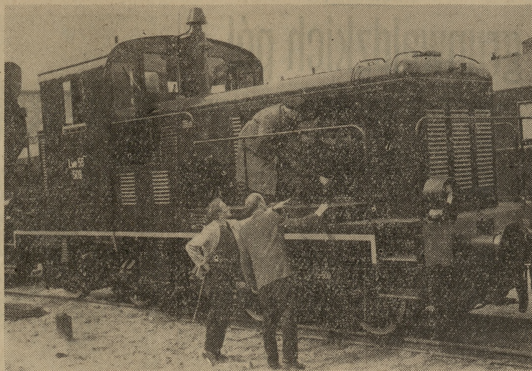
Na terenach budowy dworca centralnego podmiejskiego w Warszawie trwają przygotowania do wystawy z okazji „Dnia Kolejarza”.
