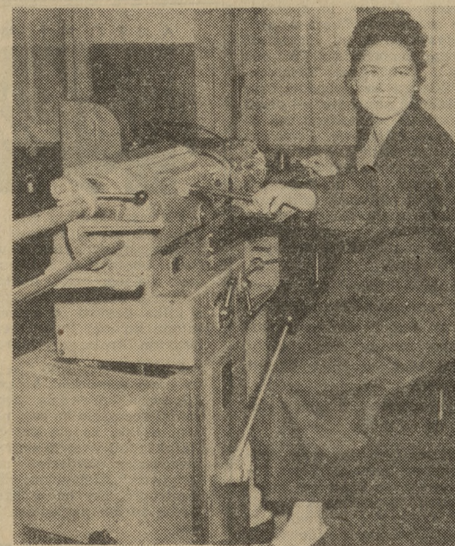
Zakłady Cegielskiego wystawiają m. in. znane z wysokiej jakości obrabiarki do metali. Na zdjęciu tokarka rewolwerowa RH 16, w której przez zastosowanie specjalnego hamulca umożliwiono zmianę obrotów silnikiem elektrycznym. Tokarkę tę można obsługiwać również w pozycji siedzącej. (Imi)
