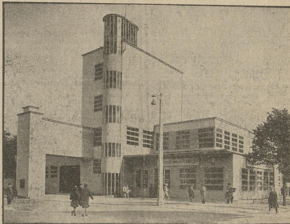
Pawilon ministerstwa poczty i telegrafów. Budynek o nowoczesnej linii architektonicznej wzniesiono z drzewa i impregnowanych płyt tekturowych, t. zw. okładziny.
