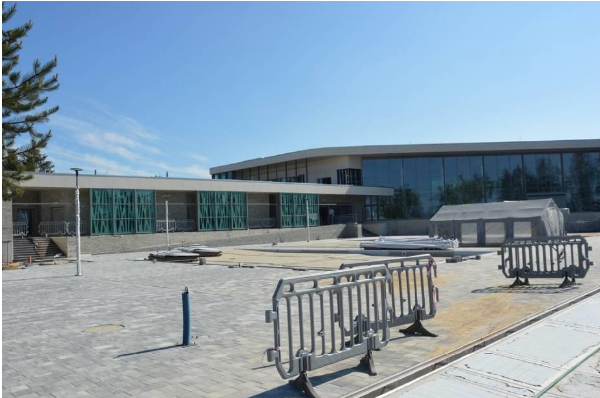
Rys. nr 44. Aktualne postępy na placu budowy Term Poddebice Źródło: www.poddebice.naszemiasto.pl , stan na czerwiec 2020r.
