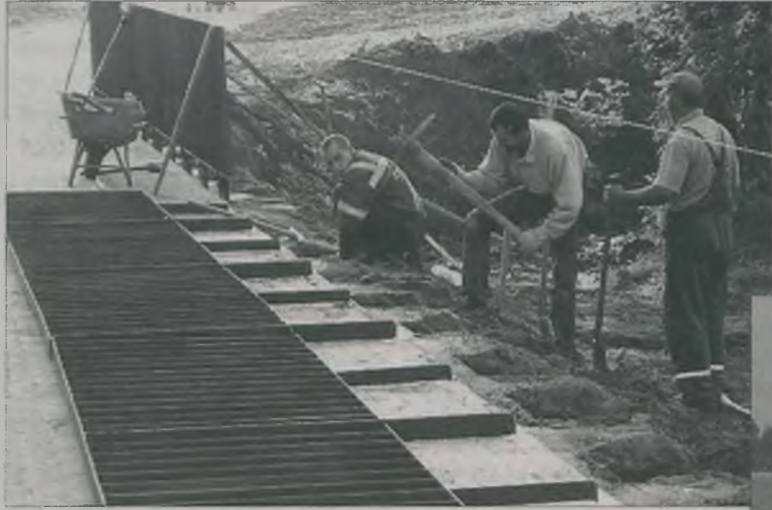
Robotnicy przy montażu barierki.
