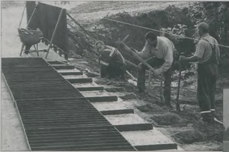
Robotnicy przy montażu barierki.
