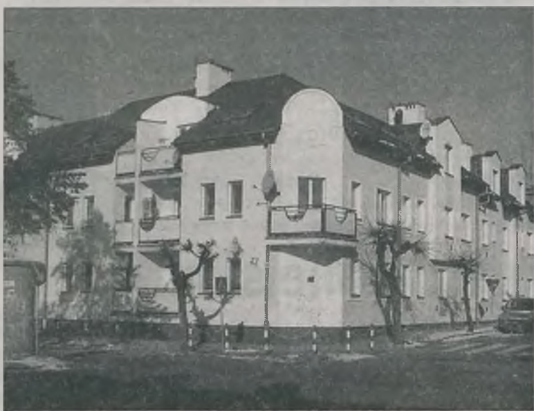
Radni zastanawiali się na przyczynach zamarznięcia instalacji wodociągowo-kanalizacyjnej w sławnej „landrynce”, liczącej dopiero 6 lat. Czyżby przyczyną awarii były błędy w wykonawstwie tej sztandarowej inwestycji poprzedniej ekipy rządzącej Turkiem.
