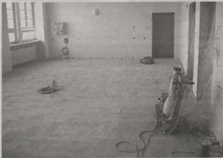
Dawniej sala posiedzeń w stylu i z elementami socrealizmu. Wkrótce nowoczesna sala konferencyjna, godna najważniejszych wydarzeń. Na zdjęciu jeszcze podczas remontu.
