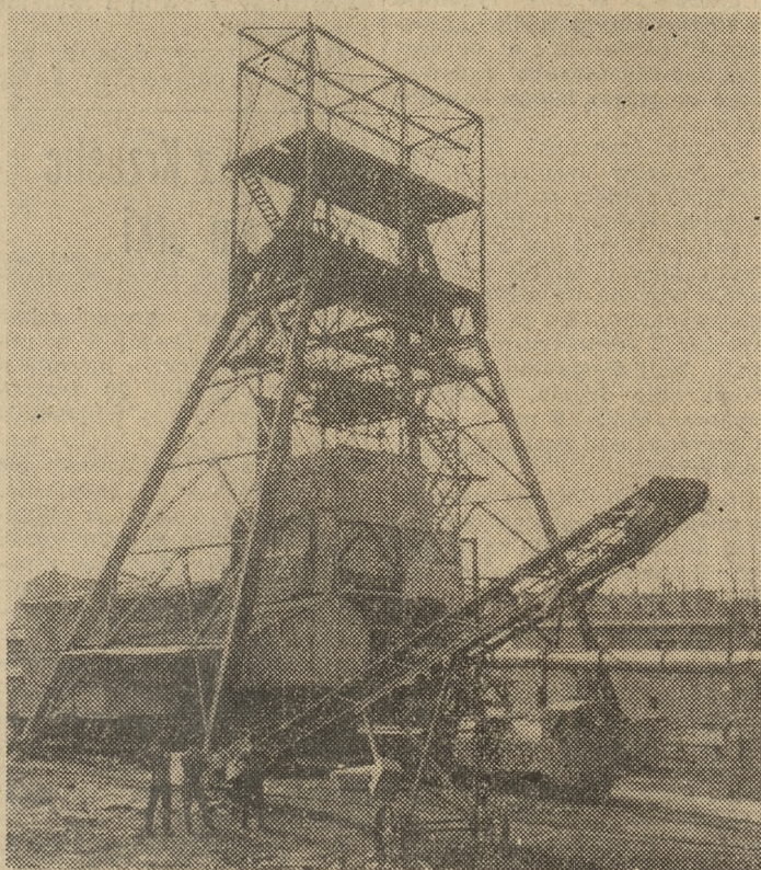
Jedną z wybudowanych kopalni w Rybnickim Okręgu Węglowym jest kopalnia „Moszczenica”, w której głębi się już pięć szybów sięgających około 500 metrów w głąb ziemi. Na zdjęciu: Fragment jednego z szybów w kopalni „Moszczenica”.
