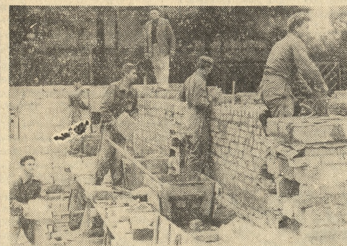
Nie, to nie zabawa. Ci młodzi ludzie to uczniowie II kl. Szkoły Rzemiosł Budowlanych na zajęciach praktycznych. Budują 4 piętrowy gmach mieszkalny przy ul. Dzierżyń-skiego. Fot. (2) K. Przychodźki
