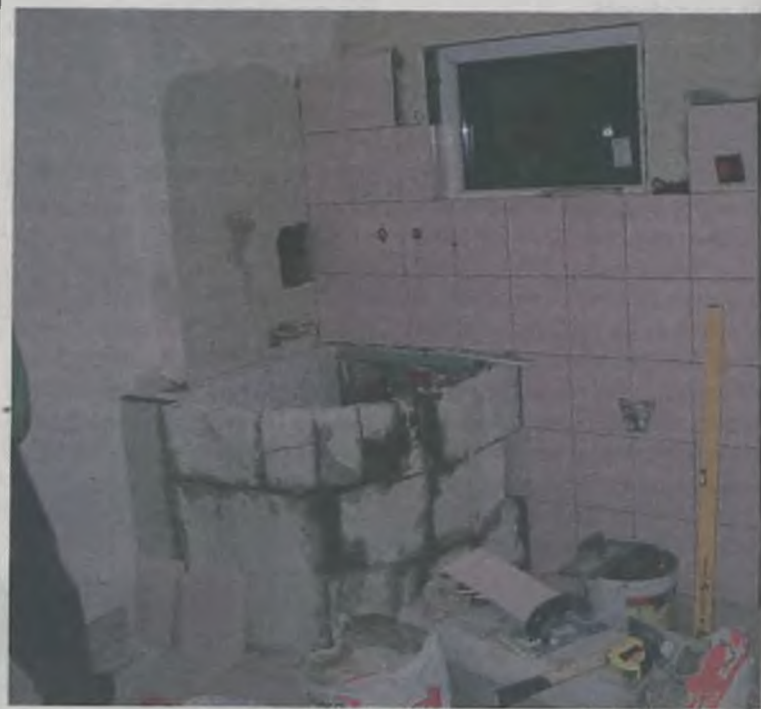
W sali zrobiono generalny remont.
