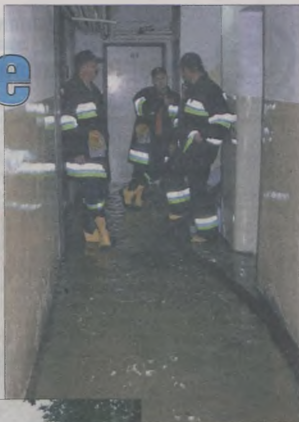
Woda nie oszczędziła także budynku komendy policji, dostała się tam poprzez deszczówkę studzienkę.
