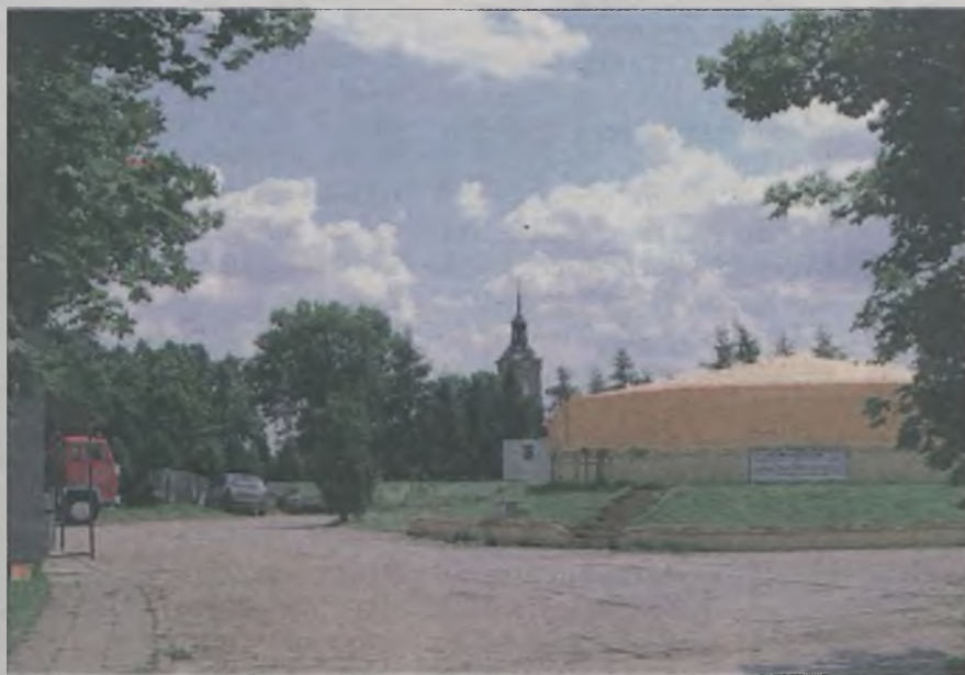
Za miesiąc, najdalej dwa, oczyszczalnia we Władysławowie znów będzie przyjmować ścieki dowożone.
