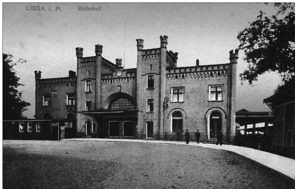
Leszno, dworzec kolejowy
