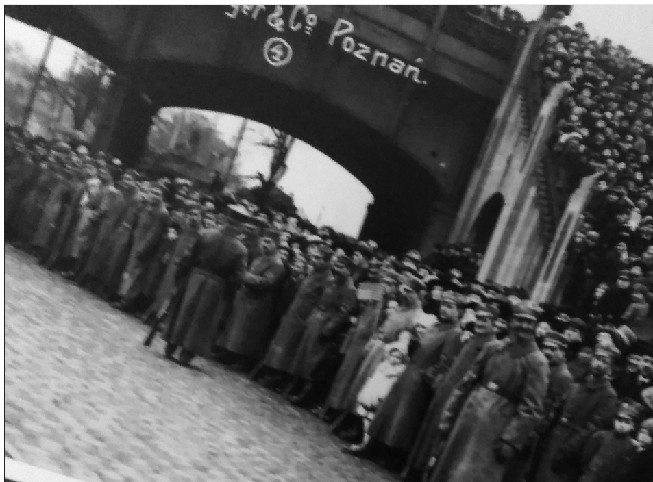
Most Dworcowy 1 marca 1919 roku był oblegany przez mieszkańców Poznania oraz członków Straży Ludowej oczekujących na przyjazd Komisji Międzysojuszniczej
