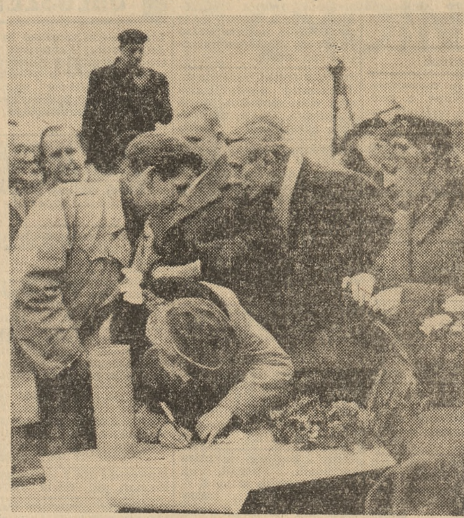
8 bm. odbyła się w Łodzi uroczystość umurowania aktu erekcyjnego pod budowę pierwszej w tym mieście szkoły Tysiąclecia. Szkoła mieścić się będzie w robotniczej dzielnicy Łodzi Bałuty i budowana zostanie przez Centralną Radę Związków Zawodowych przy pomocy społeczeństwa tej dzielnicy. Wmurowania aktu erekcyjnego dokonał członek Biura Politycznego KC PZPR, przewodniczący CRZZ — Ignacy LOGA-SOWIŃSKI.
