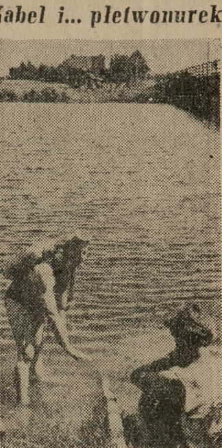
Przedsiębiorstwo Budowy Sieci Elektrycznych w Warszawie zakłada kabel elektryczny w celu zasilania placu budowy Elektrociepłowni na Siekierkach. Kabel ten miał przebiegać przez jezioro Czarniakowskie. Ponieważ istniała obawa uszkodzenia go o resztki starego mostu, leżącego na dnie jeziora, układanie kabla powierzono instruktorowi nurkowania — Jerzemu Krajewskiemu (na zdjęciu).
