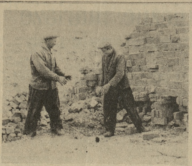
W pobliżu Łubowa (pow. gnieźnieński) buduje zagrodę Aleksander Przybowski. Cegłę wypala w piecach polowych. Zyskuje w ten sposób dobry i trwały materiał budowlany po znacznie niższej cenie. Koszt cegły wynosi tylko 35 groszy. Glinę czerpie z własnej działki, którą kupił niedawno. W zeszłym roku postawił budynek gospodarski z prefabrykatów żużlowych. (emp)
