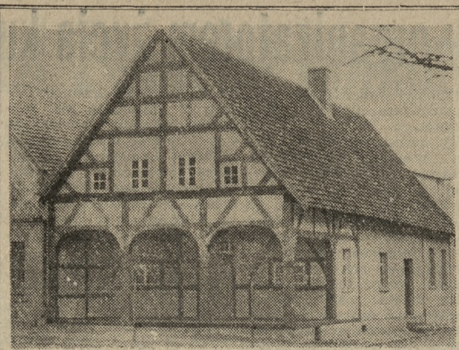
Odremontowany stary dom z podcieniami w Poniecu
