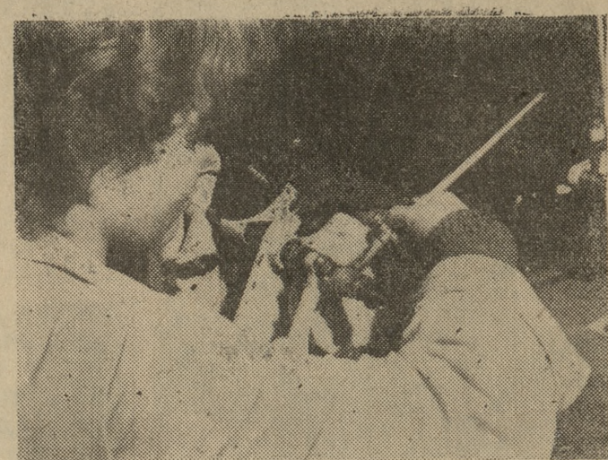
Tak wygląda nawijanie cewek wysokiego napięcia. Jest to jeden tylko detal, a telewizor składa się z kilkuset takich i podobnych detali.
