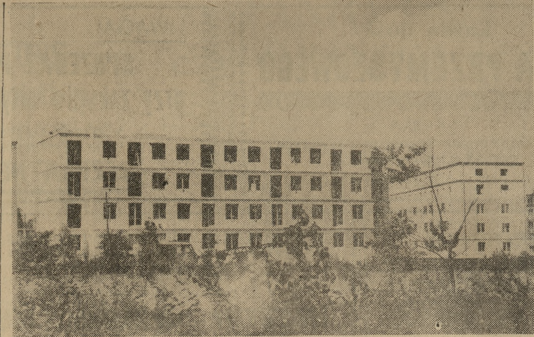
Plac budowy przy ulicy Szamarzewskiego
