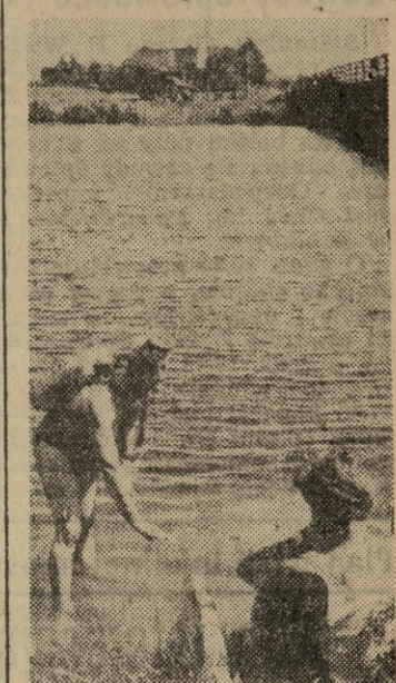
Przedsiębiorstwo Budowy Sieci Elektrycznych w Warszawie zakłada kabel elektryczny w celu zasilania placu budowy Elektrociepłowni na Siedemkach. Kabel ten miał przechodzić przez jezioro Czerniakowskie. Ponieważ istniała obawa uszkodzenia go o resztki starego mostu, leżącego na dnie jeziora, układano kable powierzchniowo instruktorowi nurkowania — Jerzemu Krajewskiemu (na zdjęciu).
