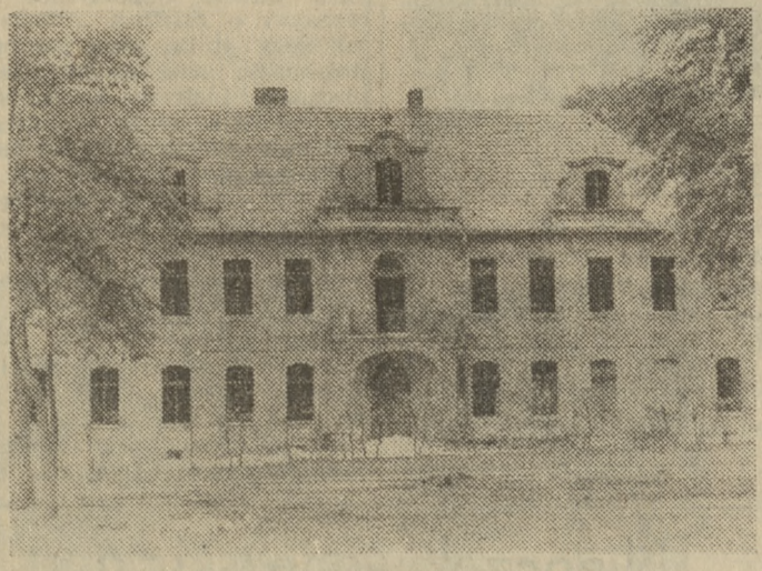
... a obok późnobarokowy pałac. W remoncie. Ma być w nim szkoła.
