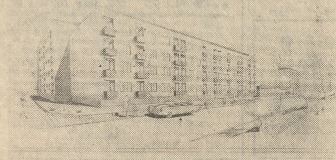
Tak ma wyglądać po ukończeniu robót osiedle przy al. Przybyszewskiego.
