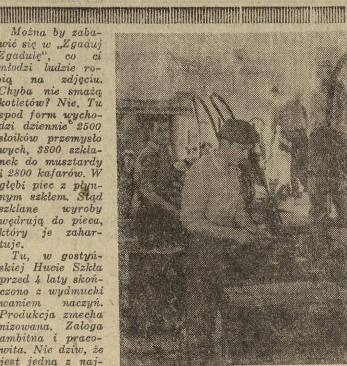
Można by zabrać się w „Zgaduj Zgadulę”, co ci młodzi ludzie robią na zdjeciu. Chyba nie smażą kotletów? Nie. Tu spod form wychodzi dziennie 2500 słoików przemyślnych, 3800 słoików do musztardy i 2800 kafarów. W głębi piec z płynnym szkłem. Stąd szklane wyroby wędrują do pieca, który je zahartuje.
