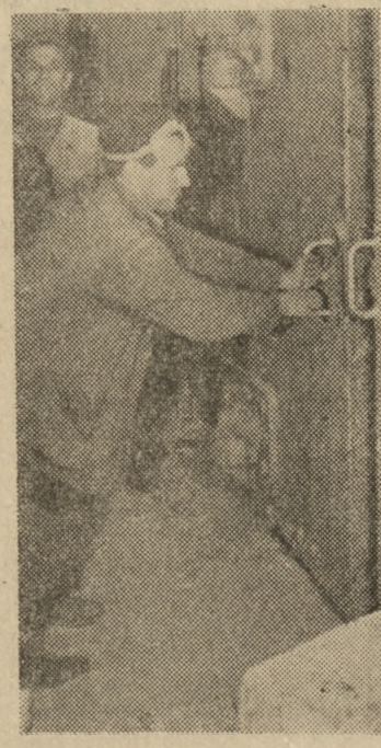
Potężna, ważąca kilka ton drzwi, zamykają wejście do stacji pomp. CAF — fot. Dąbrowiecki
