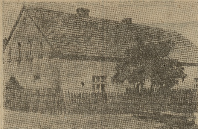
Włoszakowice — miejsce urodzenia Kurpińskiego
