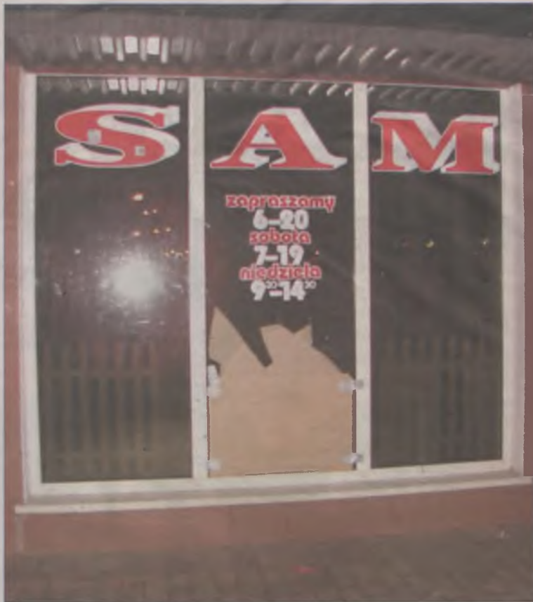
Sklep samoobsługowy przy ul. 650-lecia często pada ofiarą nocnych wandalii.
