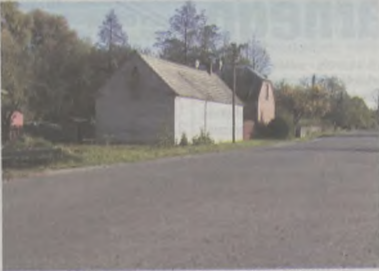
Mieszkańcy Tarnowej zwracają uwagę na katastrofalny stan poboczy biegnących przy drodze powiatowej w ich wsi. Mówią też o kiepskim oświetleniu. To, ich zdaniem, również przyczyny tragicznych wypadków samochodowych. Modernizacja oświetlenia, jak zapewnił burmistrz Grzegorz Ciesielski, będzie kontynuowana. Ale na chodnik przyjdzie mieszkańcom chyba poczekać dłużej.
