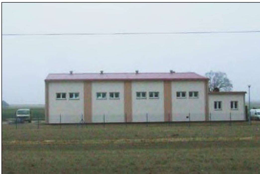
Budynek Stacji Uzdatniania Wody w Lenartowicach.
