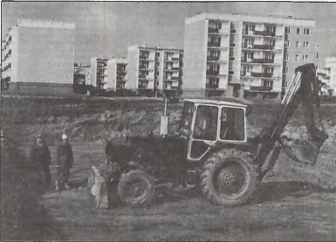
Najbardziej oczekiwana dziura w ziemi — w pięć dni po rozpoczęciu budowy SP nr 5.
