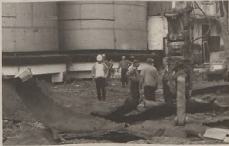
Aktualnie kopalnią złomu jest teren byłej olejarni. Demontaż metalowych elementów oraz wszystkich budynków prowadzi firma SPEC-MIN.
