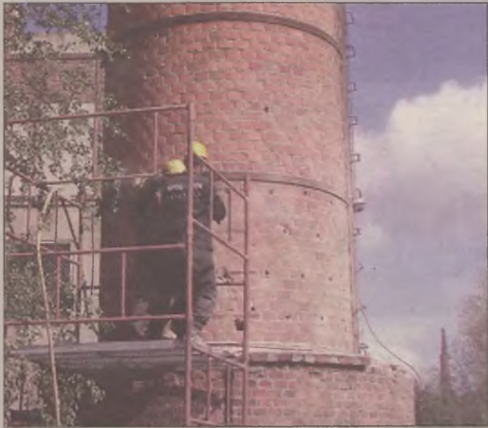
Nawiercanie otworów w ścianie komina. Tam zostały umieszczone ładunki.
