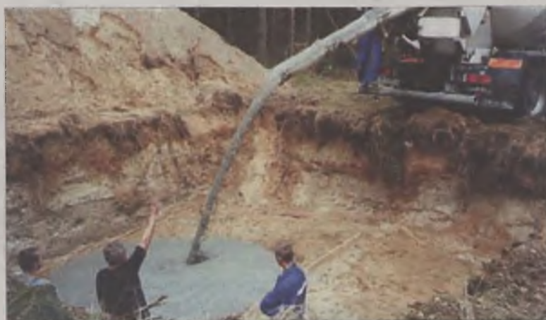
Zalewanie betonowych stóp wieży.
