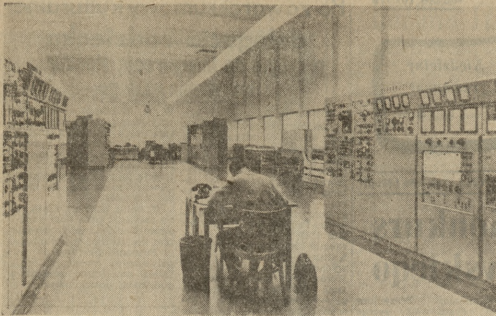
Oto nowoczesna międzynarodowa radiostacja w Usingen (NRF), gdzie krzyżują się rozmowy z Nowego Jorku, Rzymu, Belgradu, Aten, Istambu, Bejrutu, Kairu, Teheranu. Dzięki zainstalowaniu dwu nowych nadajników o mocy 100 kW marki Telefunken niezależność rozmowy telefonicznej, dalekopisy i telegramy zamorskie od zakłóceń atmosferycznych. Do kontroli pracy aparatów zainstalowanych w hali wystarcza jedna osoba, mimo że np. z samym tylko Nowym Jorkiem odbywa się dziennie około 500 rozmów.
