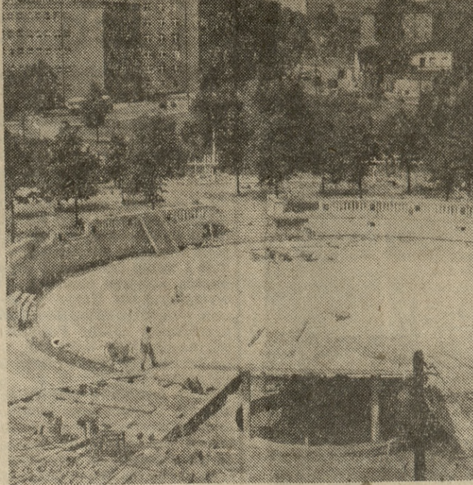
W lipcu br. ukończone będą roboty przy budowie wielkiego kręgu tanecznego w Centralnym Parku Kultury i Wypoczynku na Powiślu w Warszawie.
