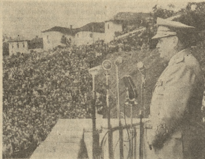
W końcu maja br. uruchomiono pierwszy agregat jednej z trzech elektrowni wodnych, budowanych w okolicy miejscowości Mavrovo (Jugosławia). Budowę tych elektrowni rozpoczęto przed dziesięć laty. Oddania do użytku pierwszego agregatu dokonał prezydent Jugosławii — J. Tito.
