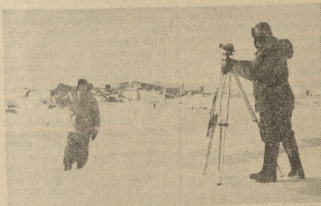
Obrazek z codziennej trudnej pracy — wypuszczanie kuli wypełnionej wodorem, dla ustalenia szybkości i kierunku wiatru.
