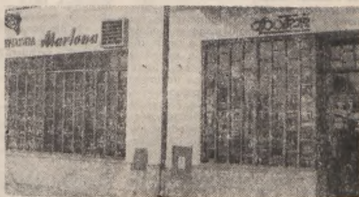
Kawiarnia „Marlena” po modernizacji
