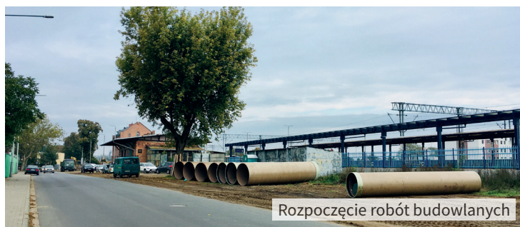
Roboty budowlane związane z budową systemu podczyszczania wód opadowych i roztopowych
