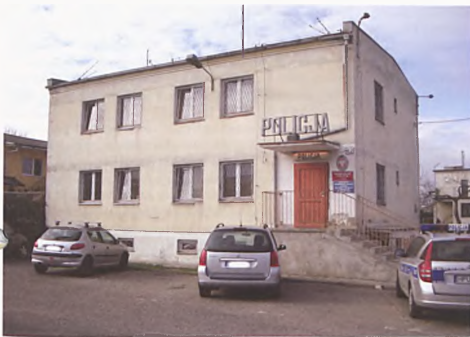
Obecny budynek Komisariatu policji w Luboniu jest w bardzo złym stanie.
