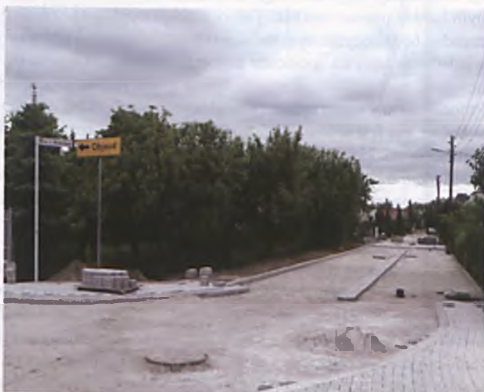
Prace przy budowie ul. Brzechwy
