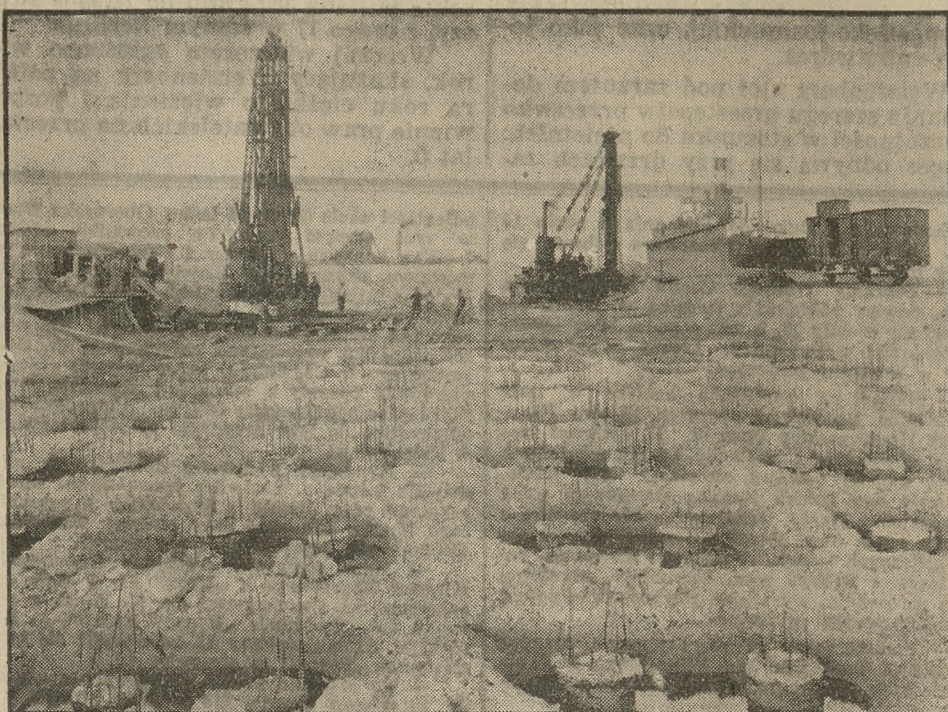
Wbijanie pali pod fundamenty dla elewatora zbożowego.
