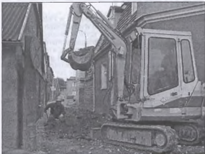
W Wąskiej — wąską koparką — kanalizację, potem w Wąskiej, wąską koparką — gaz...
