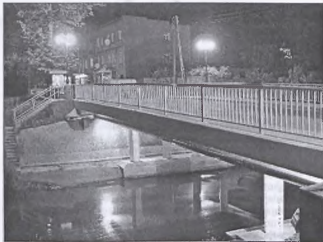
Most na ul. Niezłomnych — zamontowano cztery lampy z trzema potrójnymi kloszami, perspektywnie nawiązujące do wystroju rynku. Na iluminację mostu składa się także jego podświetlenie...
