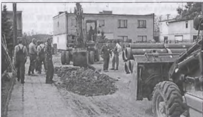
Osiedle Morena — kanalizacja rozpoczęta...
