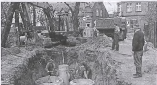
Mosina — kanalizacja w ul. Garbarskiej. Dalsze prace prowadzone będą w obrębie rynku
