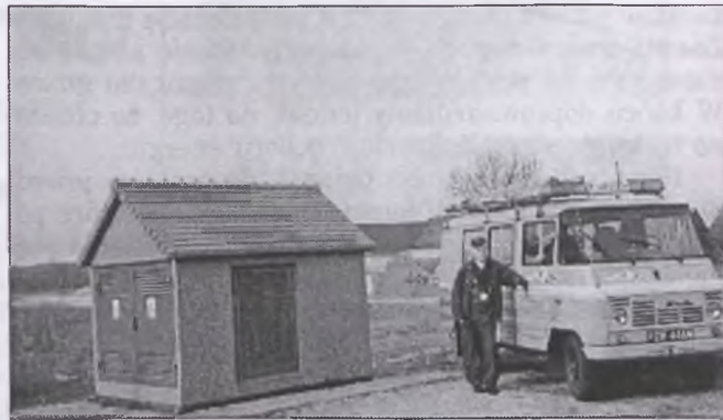
Stacja transformatorowa na terenie nowo powstającego osiedla we wsi Drużyna
