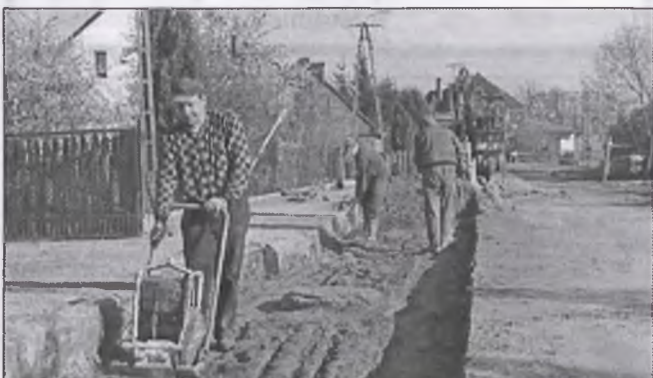
...a w Pecnej trwa drugi etap prac
