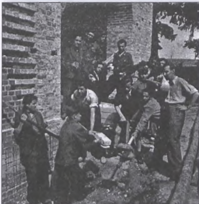
Młodzież wraz z wychowawcą Zbigniewem Miczką pracuje przy odbudowie kościoła
