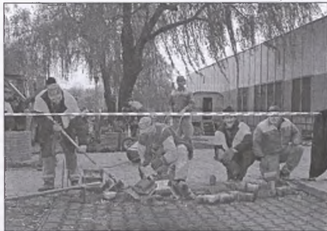
Prace przy budowie parkingu
