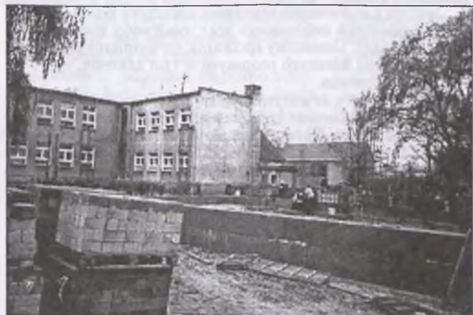
Po trzech tygodniach intensywnych prac, fundamenty pod salę gimnastyczną były gotowe
