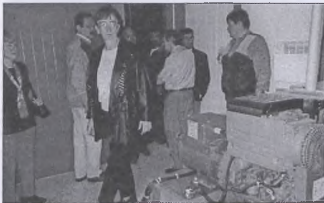
Przepompownia przy ul. Kwiatowej — w rozruchu
