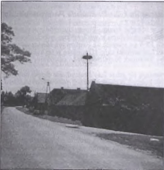
W Świątnikach ustawiony został słup, na który przeniesiono gniazdo
