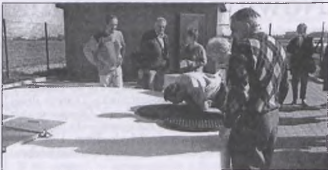
Już odprowadza ścieki
