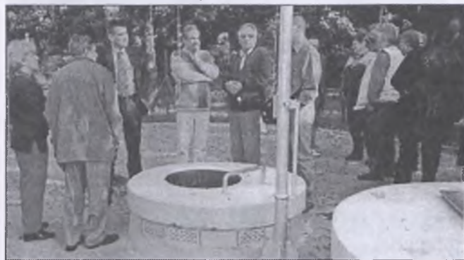
Przepompownia przy ul. Koziej — w rozruchu
