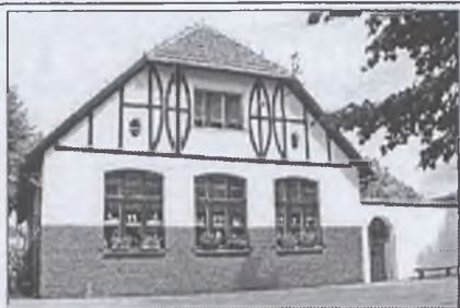
Szkolę w Krosinku przy okazji remontu rozbudowano. Znalazło się też miejsce na małą salę gimnastyczną.
