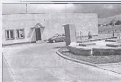
Centralna przepompownia ścieków przy ul. Wiatrowej. Oddana do użytku w 1996 r.
