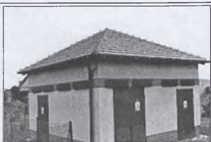
Stacja transformatorowa w Krośnice. W minionym dziesięcioleciu przybyło w mieście i gminie około 40 stacji. Łącznie jest ich 154.
