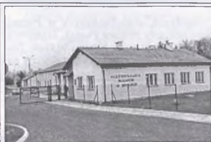
Oczyszczalnia ścieków. Budowana od października 1993 r. do grudnia 1995 r. Została oddana do użytku 17 października 1996 r. Przyjmuje coraz większe ilości ścieków. Spełnia wszelkie wymogi technologiczne i osiąga założone efekty.
