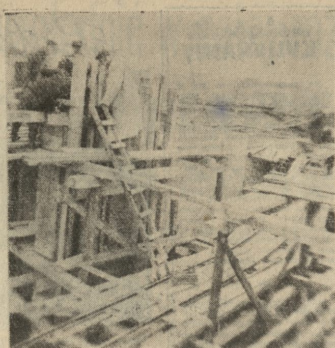
Budowa jazu dla nawożenia na rzece Orli w pow. Rawicz. Fot.: Thiel — Leszno
