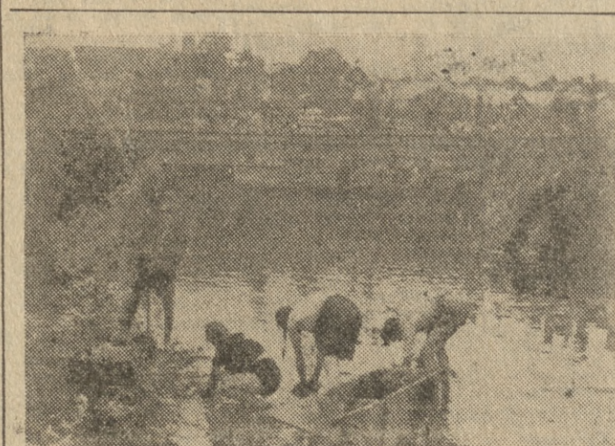
Uczniowie Technikum Ogrodniczego w Powierciu (pow. Koto) będą mieli własną, nowoczesną pływalnię. Budują ją sami wraz ze swoimi wychowawcami. Na zdjęciu: prace przy wykańczeniu dna pływalni. Fot. — J. Jakubowski
