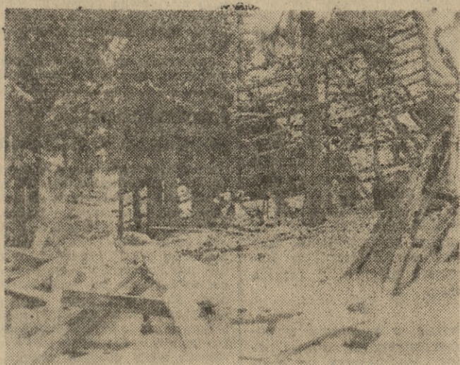
W nocy z 2 na 3 marca obsunęła się w Tatrach ogromna lawina śniegu. Lawina zeszła spod Suchego Kondradzkiego w dolinę Goryczkową, niszcząc i zasypując dwa schroniska oraz bałwimy.
